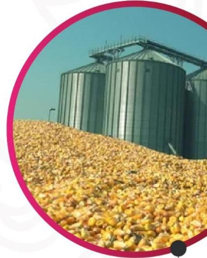
Los silos son contenedores creados para el almacenamiento o conservación de semillas y granos, como maíz. Diseñados para garantizar un almacenamiento seguro y eficiente, protegen al maíz de factores externos, manteniendo su calidad. Fabricados en acero galvanizado en distintos calibres.
